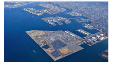
（泉大津沖埋立処分場）
