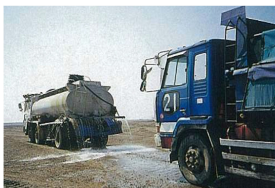
埋立処分場における場内散水
