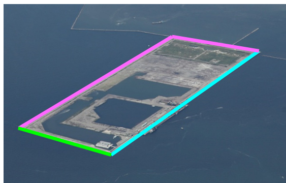
2 期神戸沖埋立処分場
