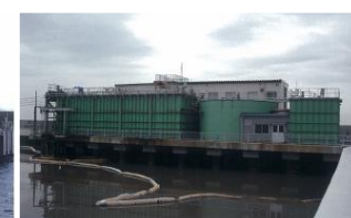
泉大津沖埋立処分場
