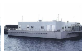
尼崎沖埋立処分場
