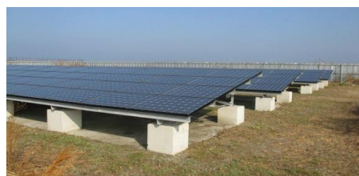
泉大津沖埋立処分場
