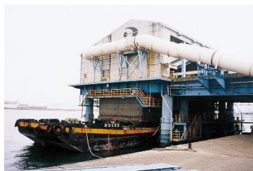
基地からの運搬船積込状況
