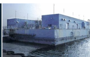
神戸沖埋立処分場
