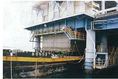
投入ホッパー下に設置した拡散防止シート
