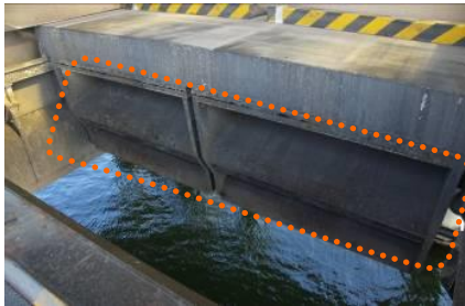
中間ダクト（集じん設備）
