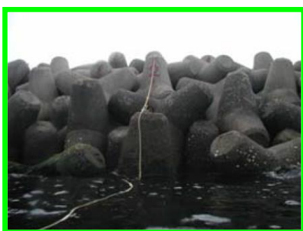
傾斜護岸（消波ブロック護岸）
