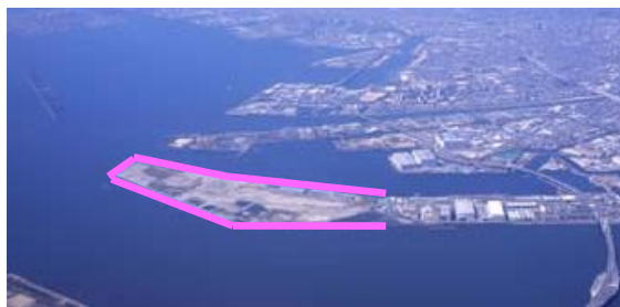
尼崎沖埋立処分場
