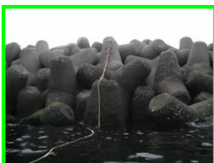
傾斜護岸（消波ブロック護岸）
