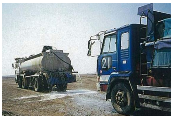
埋立処分場における場内散水
