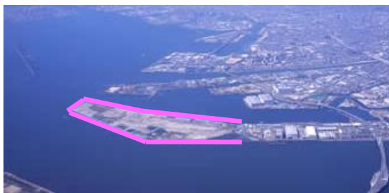
尼崎沖埋立処分場
