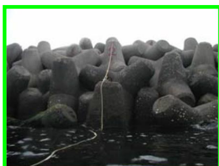
傾斜護岸（消波ブロック護岸）
