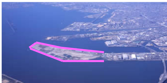
尼崎沖埋立処分場
