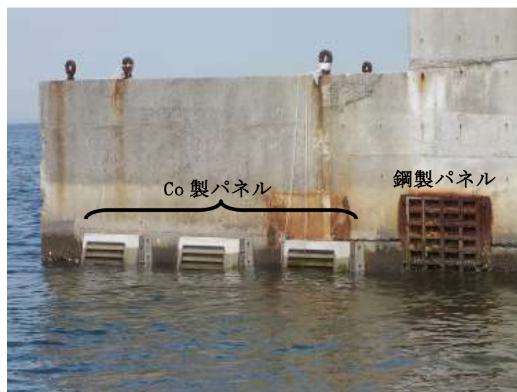
写 2-1 泉大津沖エコパネル設置状況
