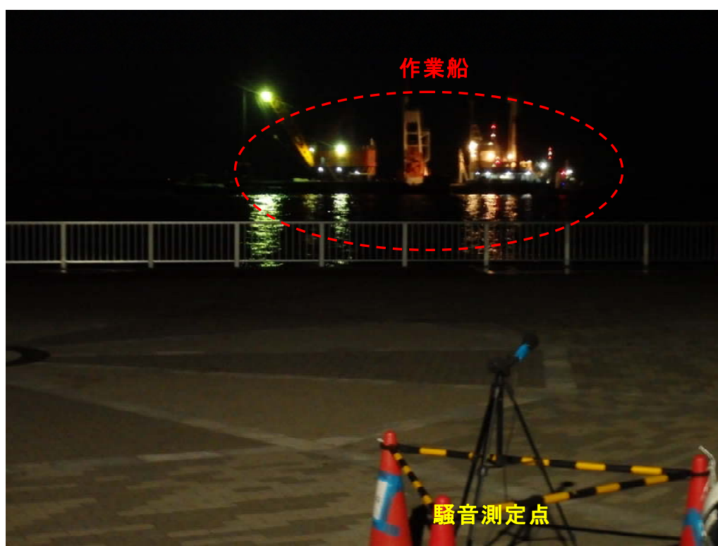
図Ⅱ-2-2 騒音調査点からみた工事作業状況
