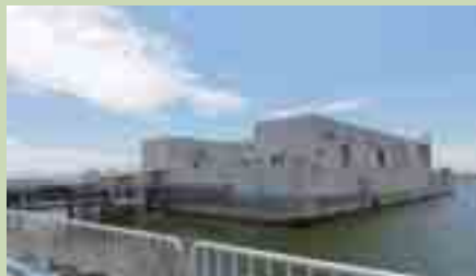
余水を排水処理施設で処理し海域の水質汚濁を防止
