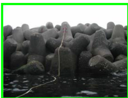
傾斜護岸（消波ブロック護岸）
