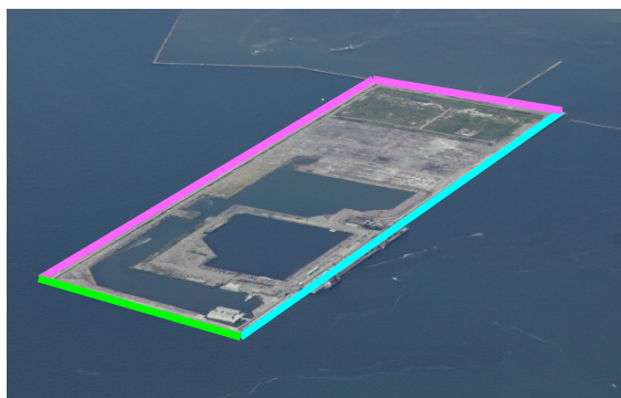
2 期神戸沖埋立処分場
