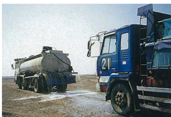
埋立処分場における場内散水
