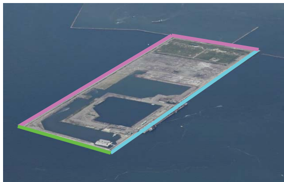
2 期神戸沖埋立処分場
