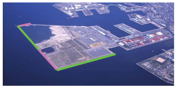
泉大津沖埋立処分場
