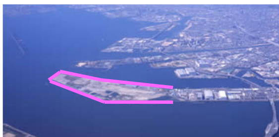
尼崎沖埋立処分場
