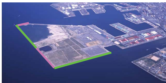
泉大津沖埋立処分場
