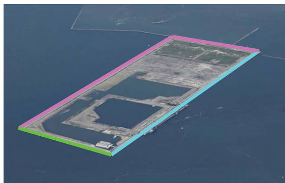
2 期神戸沖埋立処分場
