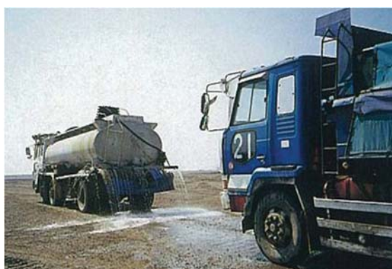
埋立処分場における場内散水
