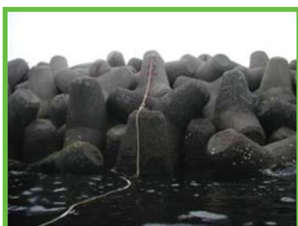
傾斜護岸（消波ブロック護岸）
