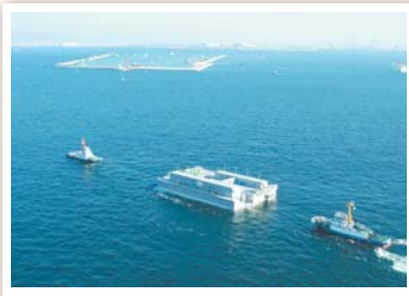
排水処理施設を船で運ぶ様子
