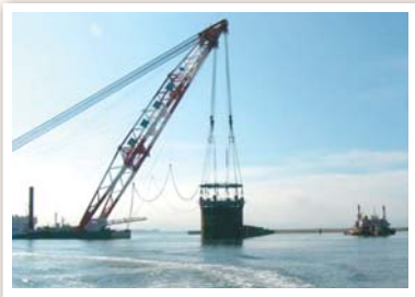
鋼板セルの設置工事の様子
