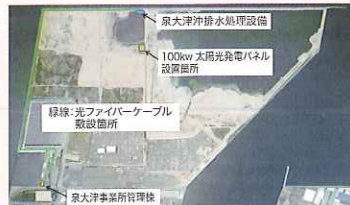
泉大津沖埋立処分場
