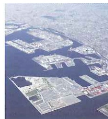
泉大津沖埋立処分場
