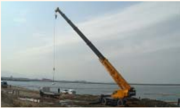
非飛散性アスベスト廃棄物受入れの様子
